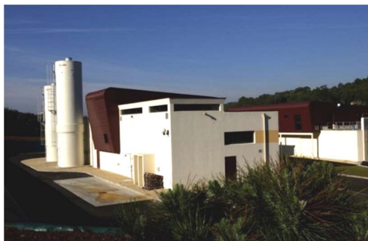
Figure 2 : Usine de production du SERTAD
